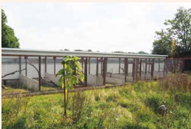
Pohled na nový blok voliér
